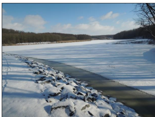
Komárovský rybník – opravená hráz.
